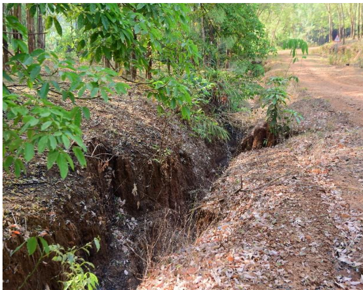
Hình 24. Xói mòn rãnh tại lô 7.8a KH
